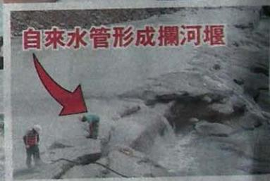
后豐大橋上游鄰近處，有一道跨河平行、以混凝土包覆的大口徑自來水管(上圖)，無意間形成第二道阻住泥沙的攔河堰，以致颱風來襲，加劇水流下切力量。水流高低落差處即為自來水管處(左圖)，加上橋墩長期缺乏淤沙保護，終至被洪水衝垮。
